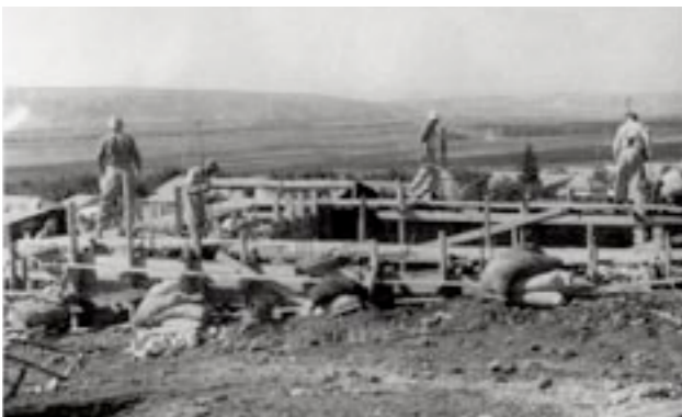
הנחת יסודות למבנה קבע, משכן לאמנות עין חרוד, 1947, צלם לא ידוע Laying the foundations for the Museum of Art, Ein Harod, 1947
